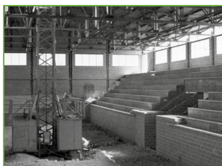
CONSTRUCCIÓN DEL PAVELLÓ ENRIQUE TIERNO GALVÁN EN 1989
